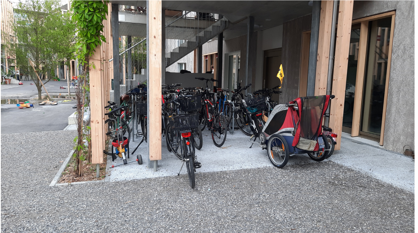
Veloabstellplätze in der Siedlung Huebergass, Bern
